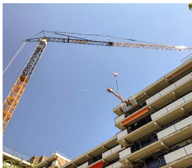
De kozijnen werden beneden beglaasd en vervolgens met een hijskraan van 40 meter hoog geplaatst.
