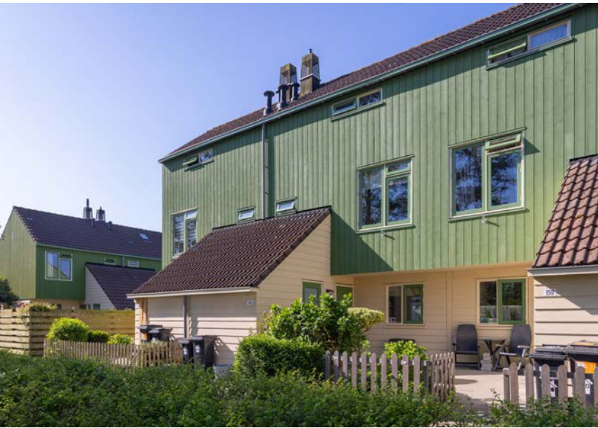
Dekker Kozijnprojecten levert en monteert nieuwe isolatie en houten gevelbekleding op 72 woningen in de wijk Dassenbos in Hoofddorp.
