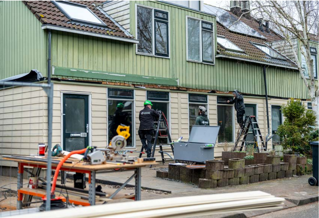
Rutges Vernieuwt renoveerde en verduurzaamde 72 woningen in de Hoofddorpse straat Dassenbos.
