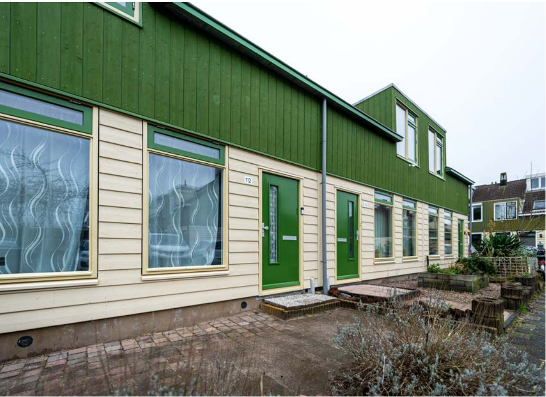
Kozijnen werden gerepareerd en voorzien van nieuwe draaiende delen.
