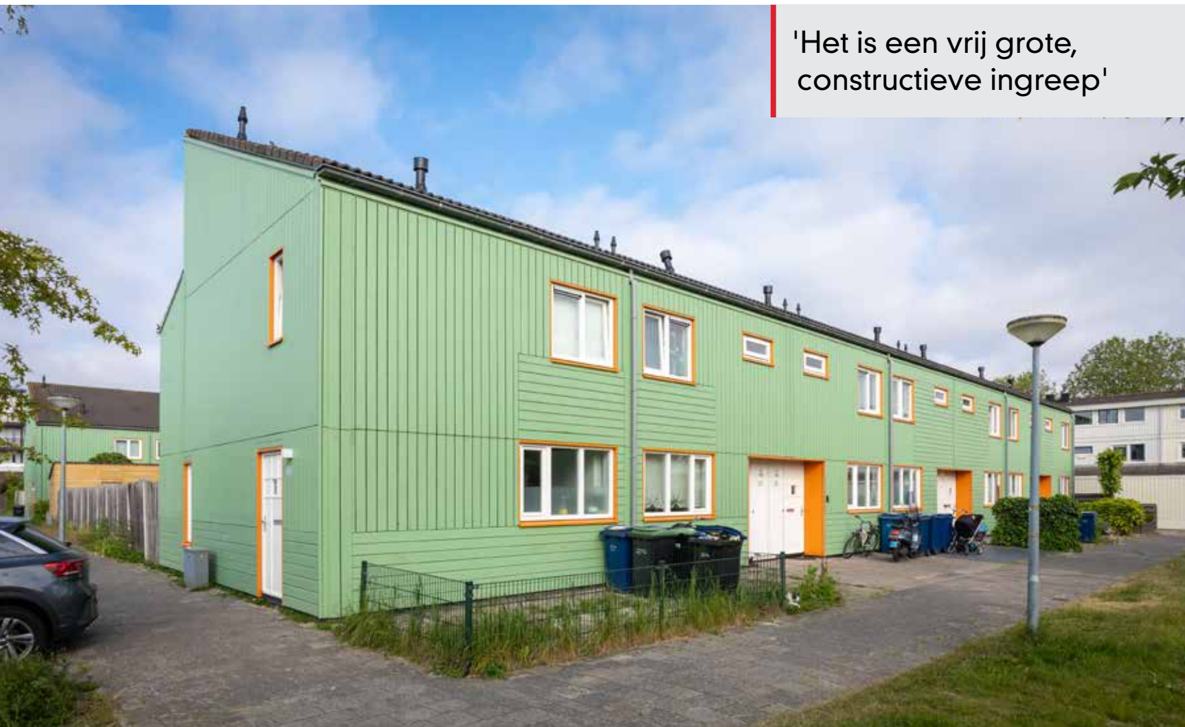
De gevelelementen zijn vooraf al voorzien van kozijnen.
