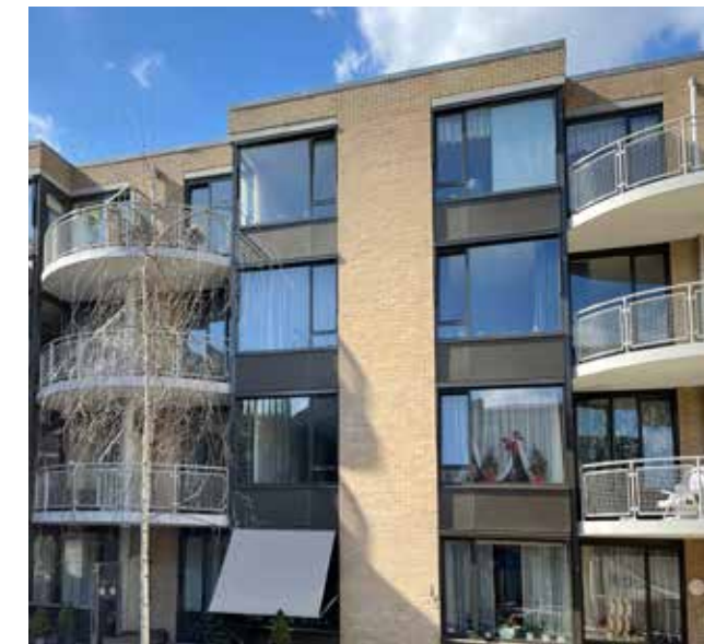
Gevels, wanden en vloeren werden beter geïsoleerd en overal werden nieuwe aluminium raampartijen met hoogrendementsbeglazing geïntegreerd.
