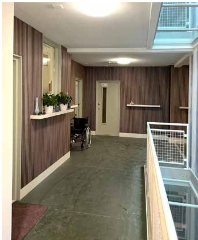
De wanden, deuren en plafonds in entrees, gangen, gemeenschappelijke ruimtes en trappenhuizen werden grondig aangepakt.
