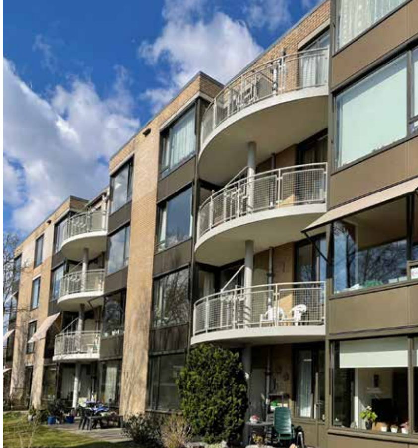
In 2019 besloot Dudok Wonen om de Van Speijkflat grondig te renoveren en verduurzamen met als doel om het comfort voor de senioren te verbeteren.
