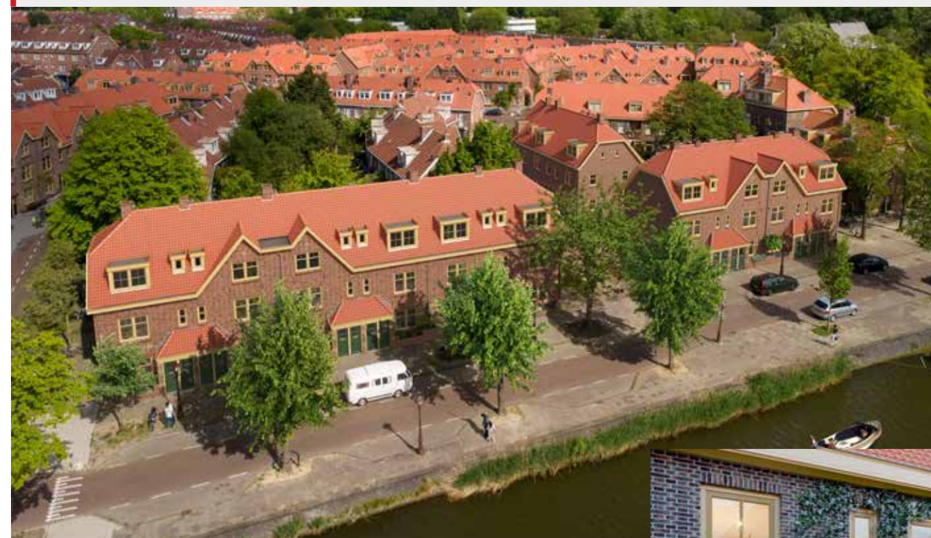
Dak, dakkapellen en kozijnen zijn hersteld of vervangen.
