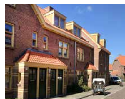
De vervangende dakkapellen en kozijnen hebben de oorspronkelijke detaillering, afmetingen en kleuren.
