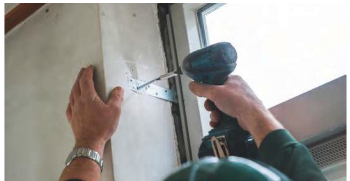
Bevestiging van het kozijn met 'zelftappende' schroeven
