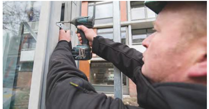
Montage van de bevestigingsstrips of 'vlaggetjes'
